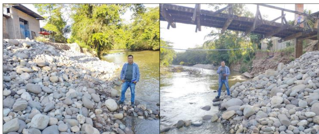
FIGURA N°02. SE APRESIA EROSION EN LA RIBERA DE LA QUEBRADA ALAO, AFECTANDO LOS BORDOS DE LA RIBERA, CON PROBABLE COLAPSO DE VIVIENDAS E INFRAESTRUCTURA EN EL SECTOR SAN MARTIN, CERCAS AL CAUCE DE LA QUEBRADA ALAO.
